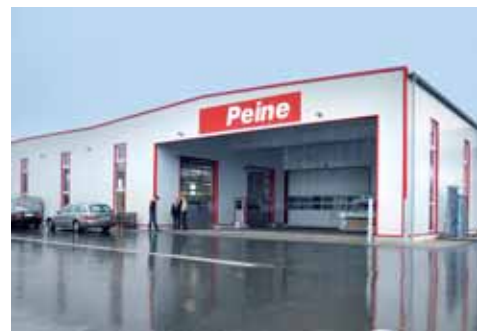
Die neue Halle für die Kunststofffenster-Produktion mit einer Gesamtfläche von rund 3.000 Quadratmetern
